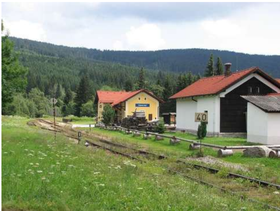
Obrázek 72 Železniční stanice Kubova Huť
