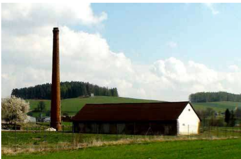
Obrázek 149 zachovaný komín po bývalé cihelně
