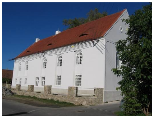
Obrázek 48 Synagoga po rekonstrukci
