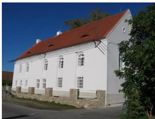
Obrázek 48 Synagoga po rekonstrukci
