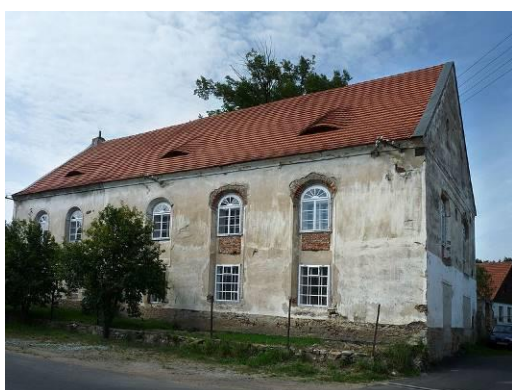
Obrázek 47 Synagoga před rekonstrukcí
