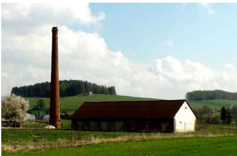
Obrázek 149 zachovaný komín po bývalé cihelně
