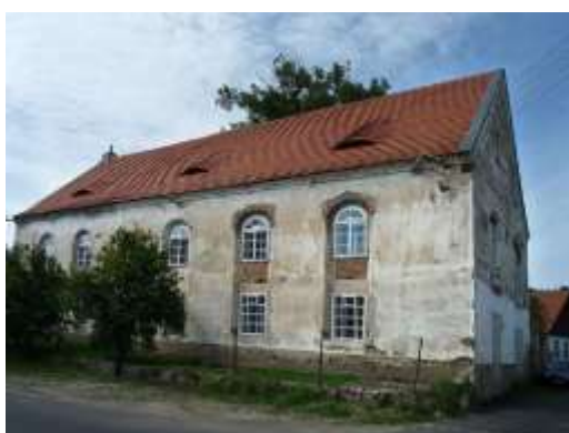
Obrázek 47 Synagoga před rekonstrukcí
