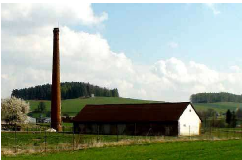
Obrázek 149 zachovaný komín po bývalé cihelně
